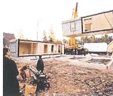
Figur 2.3 Montering av modul
