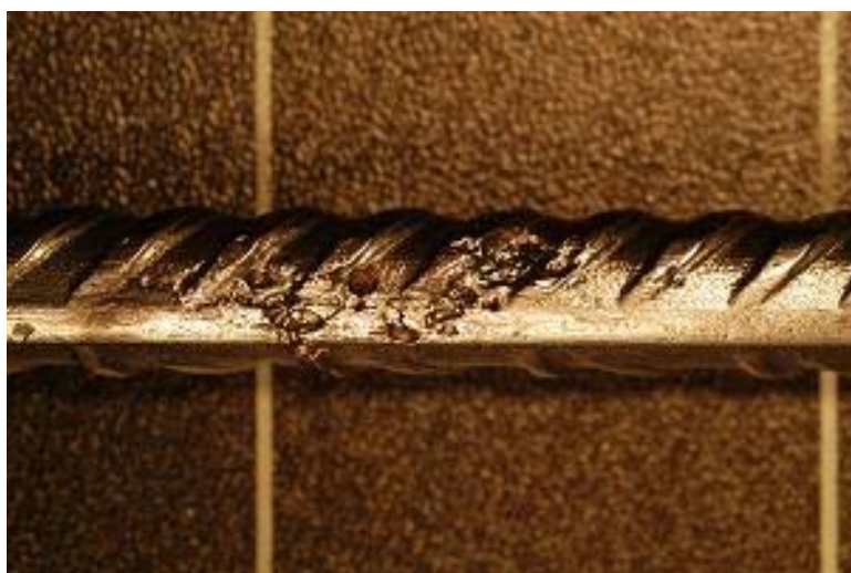
Figur 6.13 Korrosionsangrepp på järn 1 i balk 5 med täcksikt c=20 mm, stålspänning 380 MPa och diameter 8 mm kloridbelastning underifrån, gradering 3.
