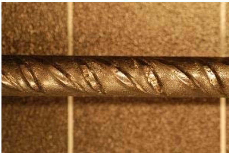
Figur 6.15 Korrosionsangrepp på järn 1 i balk 6 med täcksikt 40 mm, stålspänning 380 MPa och diameter 8 mm kloridbelastning underifrån, gradering 1.
