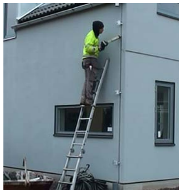
Figur 7.12 - Fogning av lodrät skarv
