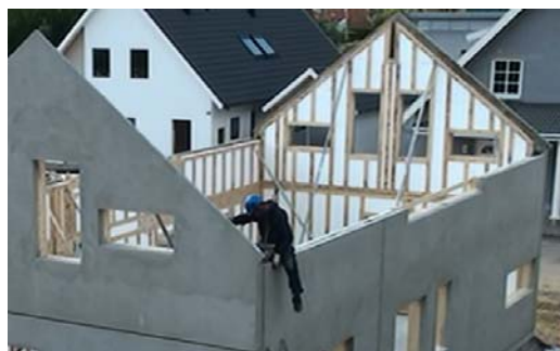
Figur 7.10 - Efterlagning av Combi-element
