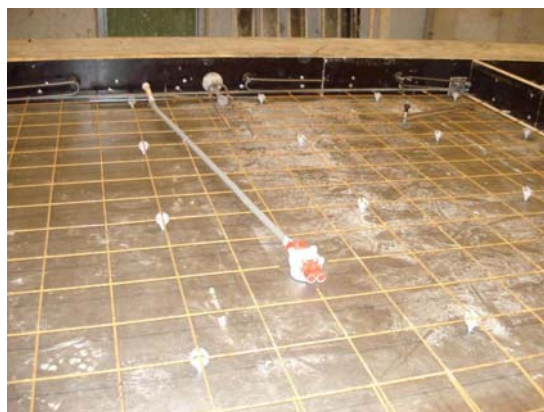
Figur 7.3 - Armering placerad på formbord
