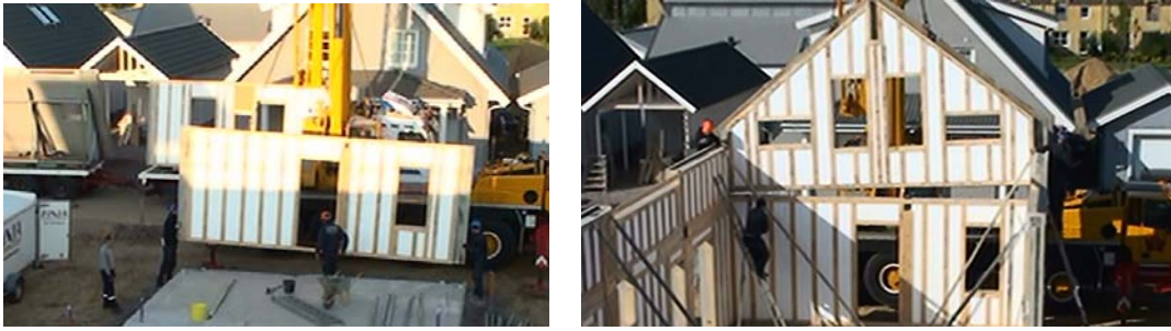
Figur 7.6 - Montering av Combi-element
