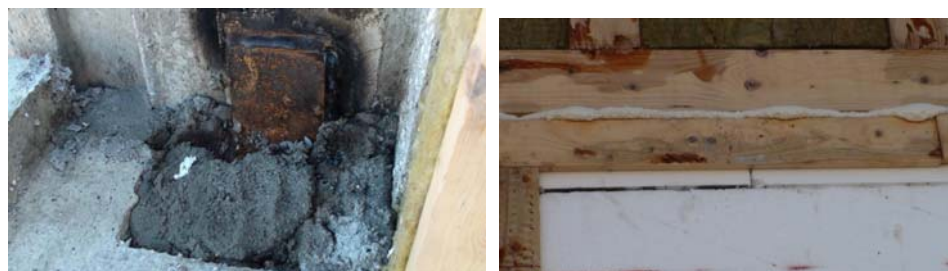
Figur 7.9 - Den vänstra bilden visar en ingjuten svetsplatta och bilden till höger visar en invändigt skummad skarv
