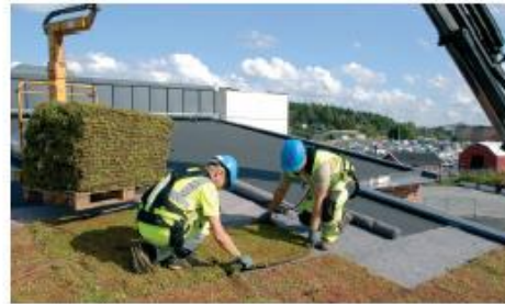
Montering på ett lutande tak med VT-filt som underlag
