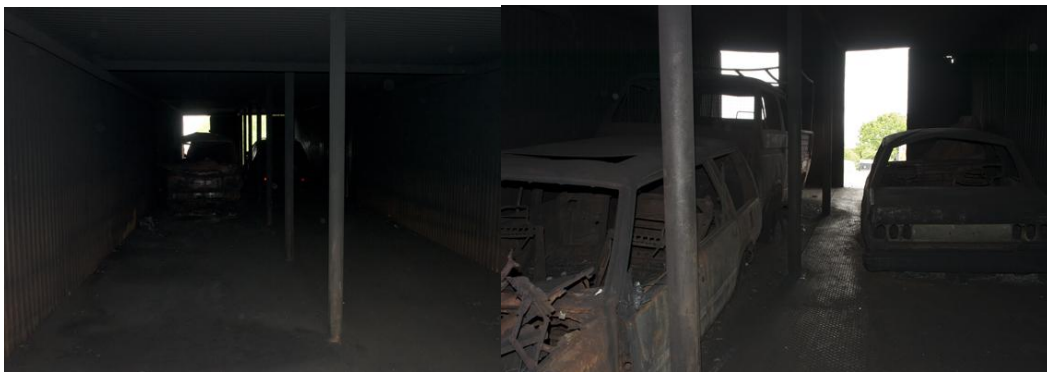
Figur 11. Foto från mitten av tunneln samt tunnelmyningen sett inifrån tunneln.
