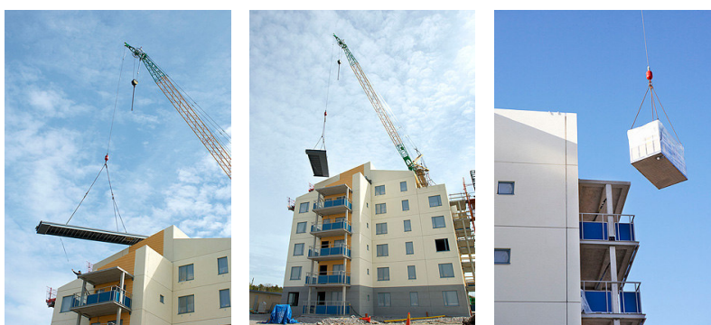
Figur 12 – Inlyftning av prefabricerade byggdelar.
