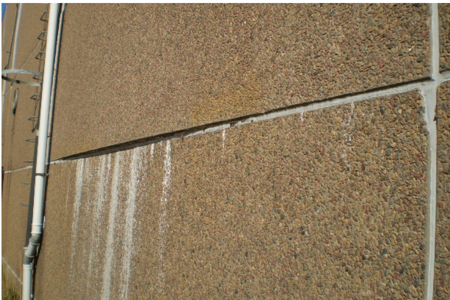
Figur 19 - Elementen med frilagd yta har en tendens till kraftig utböjning på mitten.
