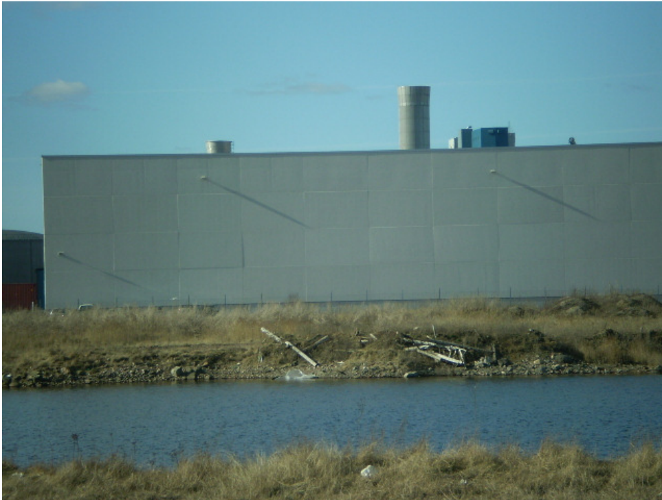
Figur 20 - Elementen "gapar" i kanterna vilket syns tydligt i släpljus.
