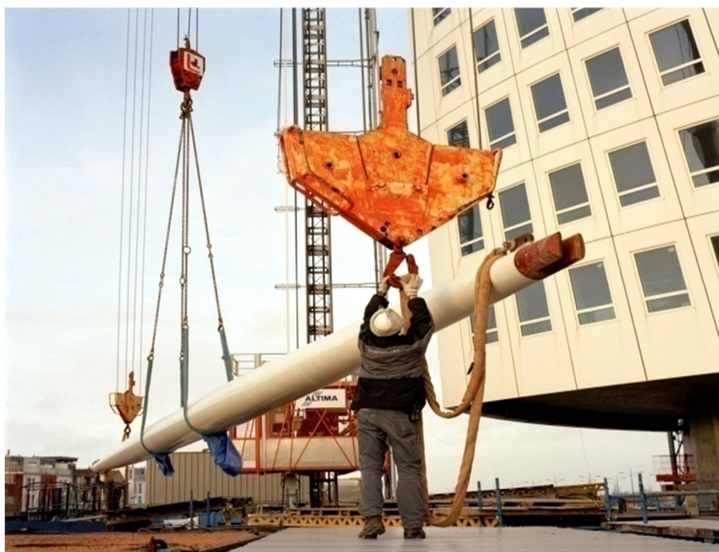
Figur 22 Dubbellyft av stålelement vid byggande av Turning Torso
