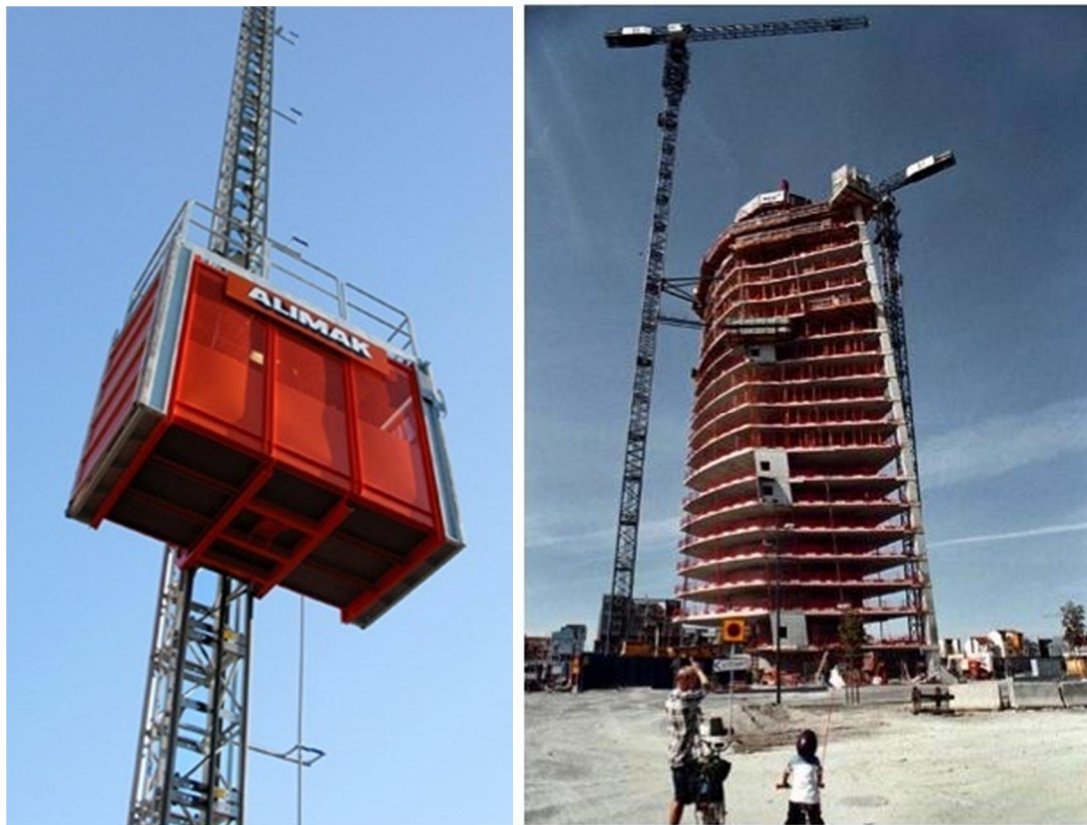
Figur 15 Bygghiss (t.v.) och Tornkran (t.h.) som användes vid Turning Torso
