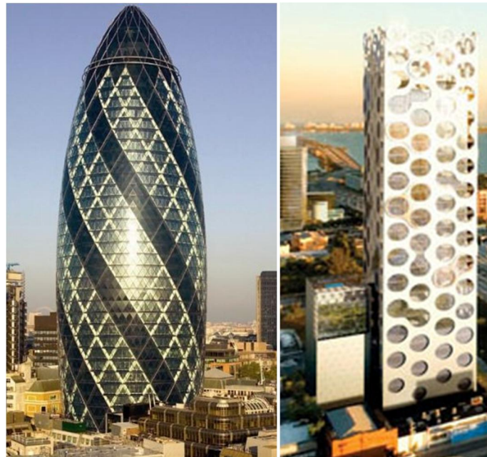
Figur 13, t.v. 30 St Mary Axe, London, ” diagrid-system ” i stål; t.h. COR - Building, Miami, ” diagrid-system ” i betong.
