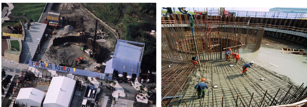
Figur 21, t.v. Stålplanken skjuts ner i berggrunden t.h. Gjutning av källarplanen vid Turning Torso
