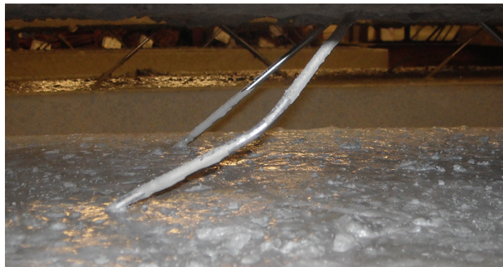
Bild 2.3 Bilden visar en diagonal i stegen som knäckts av belastning.
