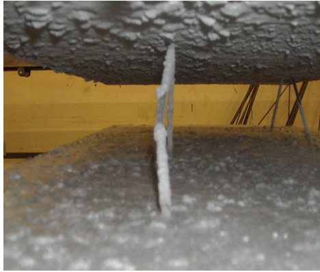
Bild 2.4 Bilden visar en diagonal i stegen som knäckts av belastning.
