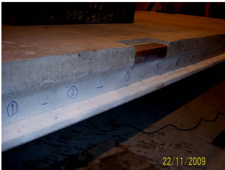
Figur 4-5 Observerade sprickor längs platta 2. Inringade siffror och streck är befintliga respektive nyuppkomna sprickor.
