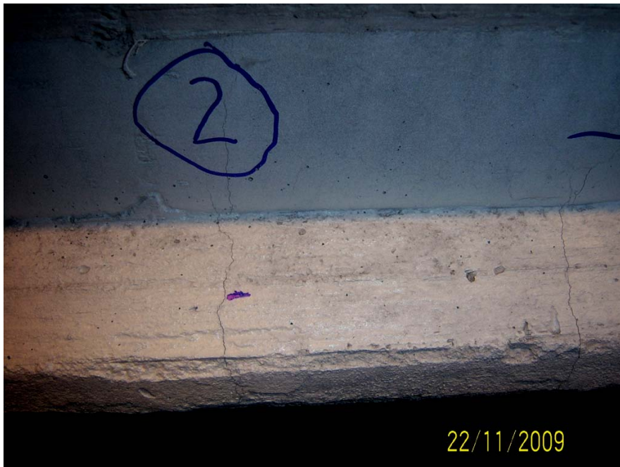
Figur 4-6 Befintliga och nyuppkomna sprickor.
