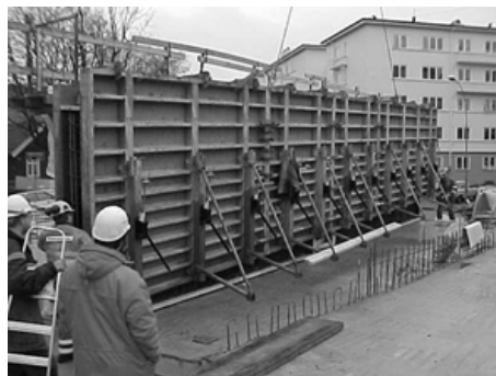
Figur 3.2 Bostadsform för vägg (Betongbanken 2008)
