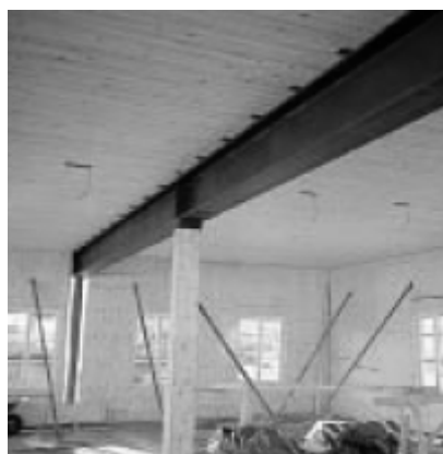
Figur 5.20 Pelar - balksystem (Massivträ Handboken, 2006)
