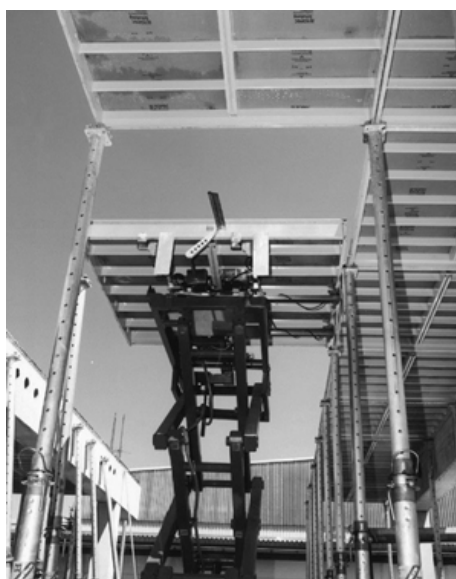
Figur 3.1 Luckform för valv (Betongbanken 2008)
