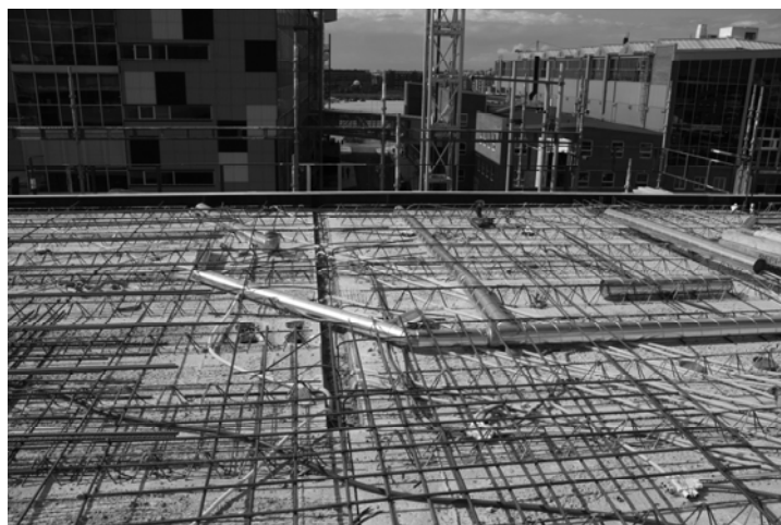
Figur 5.4 Plattbärlag med installationer och armering, (Eget foto)
