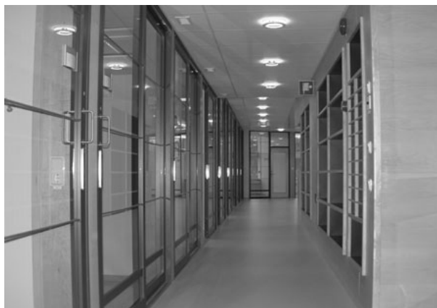
Figur 5.8 Undertak i kontorskorridor, (Flex Systemväggar, 2008)
