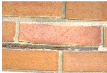
Bild 3.3 Blottade armeringsstänger och böjt tegelskift
