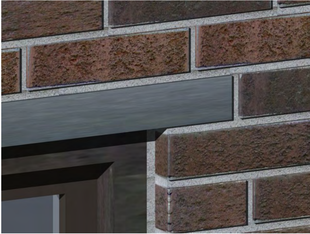
Bild 4.10a Fönsterhörn med liggande vkr-profil (120x60x5 mm) av varmgalvaniserat stål.
