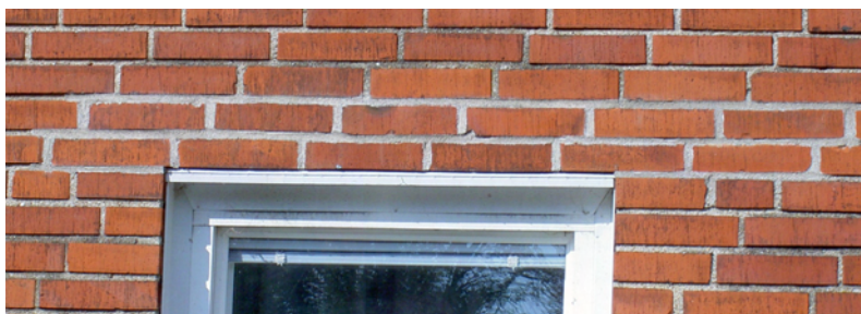
Bild 4.6 Exempel på ersättningsfogar med större bredd än ursprunglig
