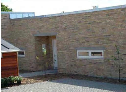
Bild 3.8 Armerade betongbalkar ovanför öppningar, Bjørnebakken, Danmark
