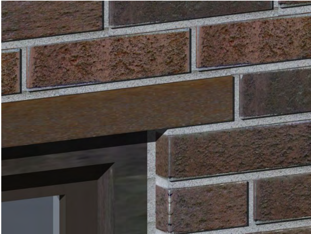
Bild 4.10b Fönsterhörn av liggande vkr-profil (120x60x5 mm) och rostig yta.
