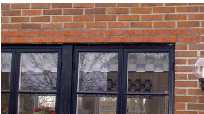
Bild 3.5 Ersättningstegel och fog med kulör avvikande från originalet
