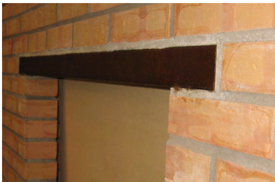
Bild 4.14a Liggande vkr-profil med måtten 60x120x5 mm
