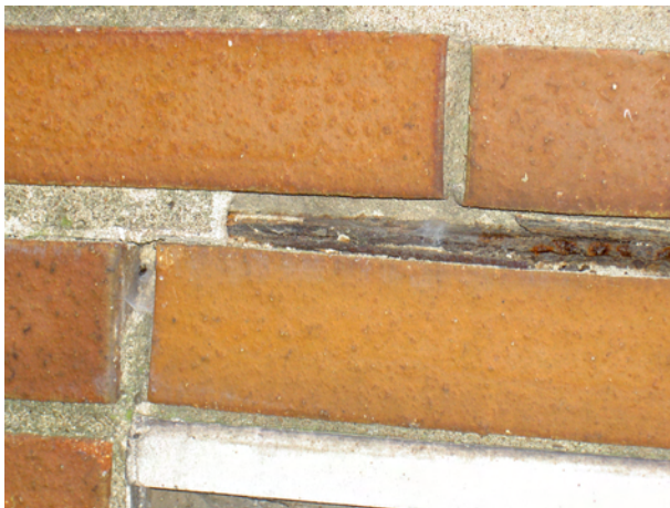
Bild 4.1 Exempel på skador ovanför öppningar i en skalmur
