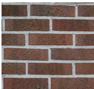
Bild 4.16a En bit av en tegelvägg.
