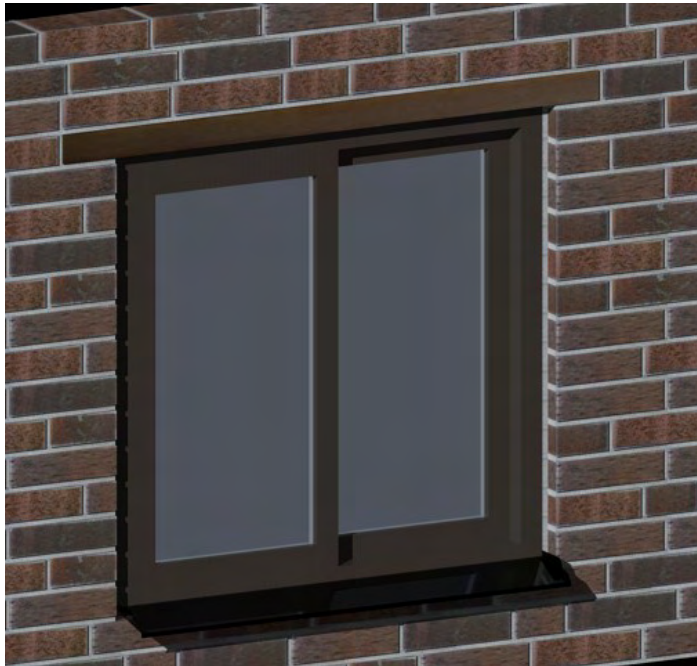
Figur 4.9b Fönster med liggande vkr-profil (120x60x5 mm) och rostig yta.
