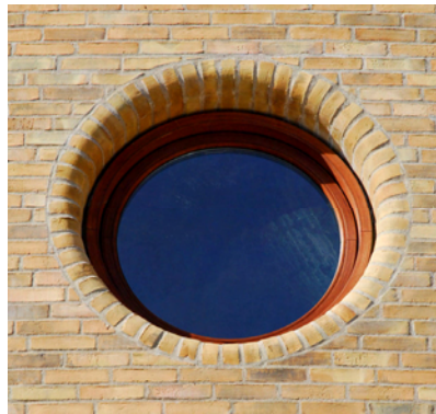
Bild 3.7 Exempel på en slakarmerad öppning
