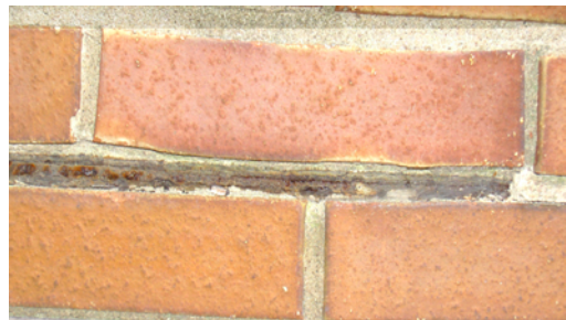
Bild 2.9b Blottade armeringsstänger på Vildanden, Lund
