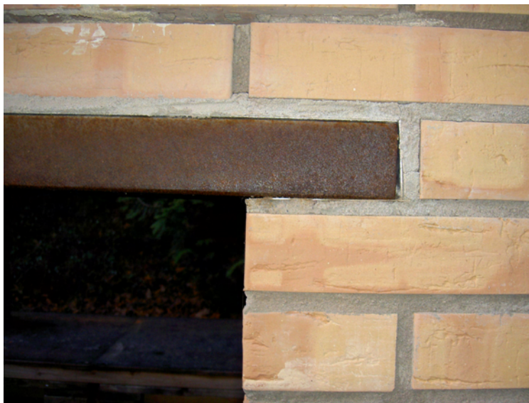
Bild 3.10 Murverk överbyggt med en rostad VKR-stålprofil i fullskala
