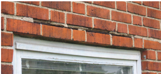
Bild 2.9a Blottade armeringsstänger, Klosters Fälad, Lund
