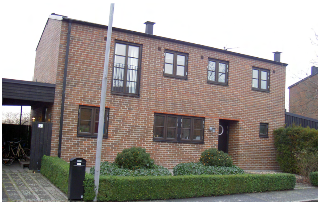
Bild 4.15 Avvikande ersättningsmaterial på både tegel och murbruk, Bygglovsvägen, Lund
