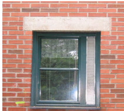
Bild 3.9 Armerad betongbalk ovanför en öppning, Bredgatan, Lund
