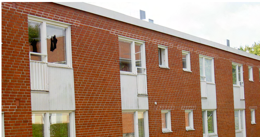
Bild 4.4 Reparerade fogar i avvikande kulör, Måsvägen, Lund
