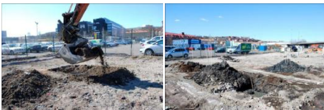
Figur 14. Den vänstra bilden visar uppgrävningen av en av schakthögarna som skulle provtas. Bilden till höger visar de fyra uppgrävda schakthögarna. Antalet stäckäppar (1-4 st) i varje schakthög visar högens identitet.
