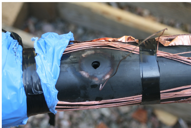
Bild 2: Första metoden, sönderborrad 10 kV kabel
