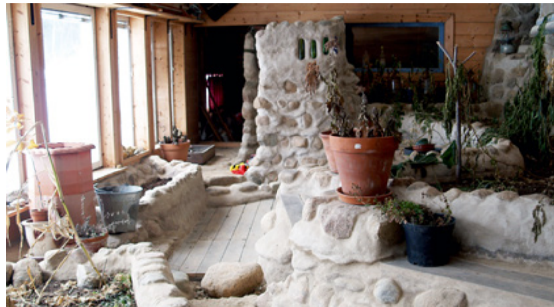
I växthusdelen odlas den mesta maten, i form av frukt och grönsaker. Men det är också här solens strålar kommer in genom stora fönster och lagras i sten och däck för att strömma ut under natten.
