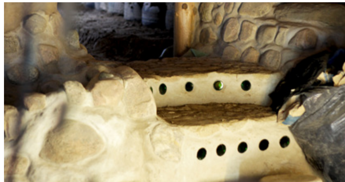
Allt inuti huset är gjort av stenar från marken utanför och cement. Glasflaskor och annat återvinningsmaterial har använts för att fylla ut cementblandningen så att det går åt så lite som möjligt av den.
