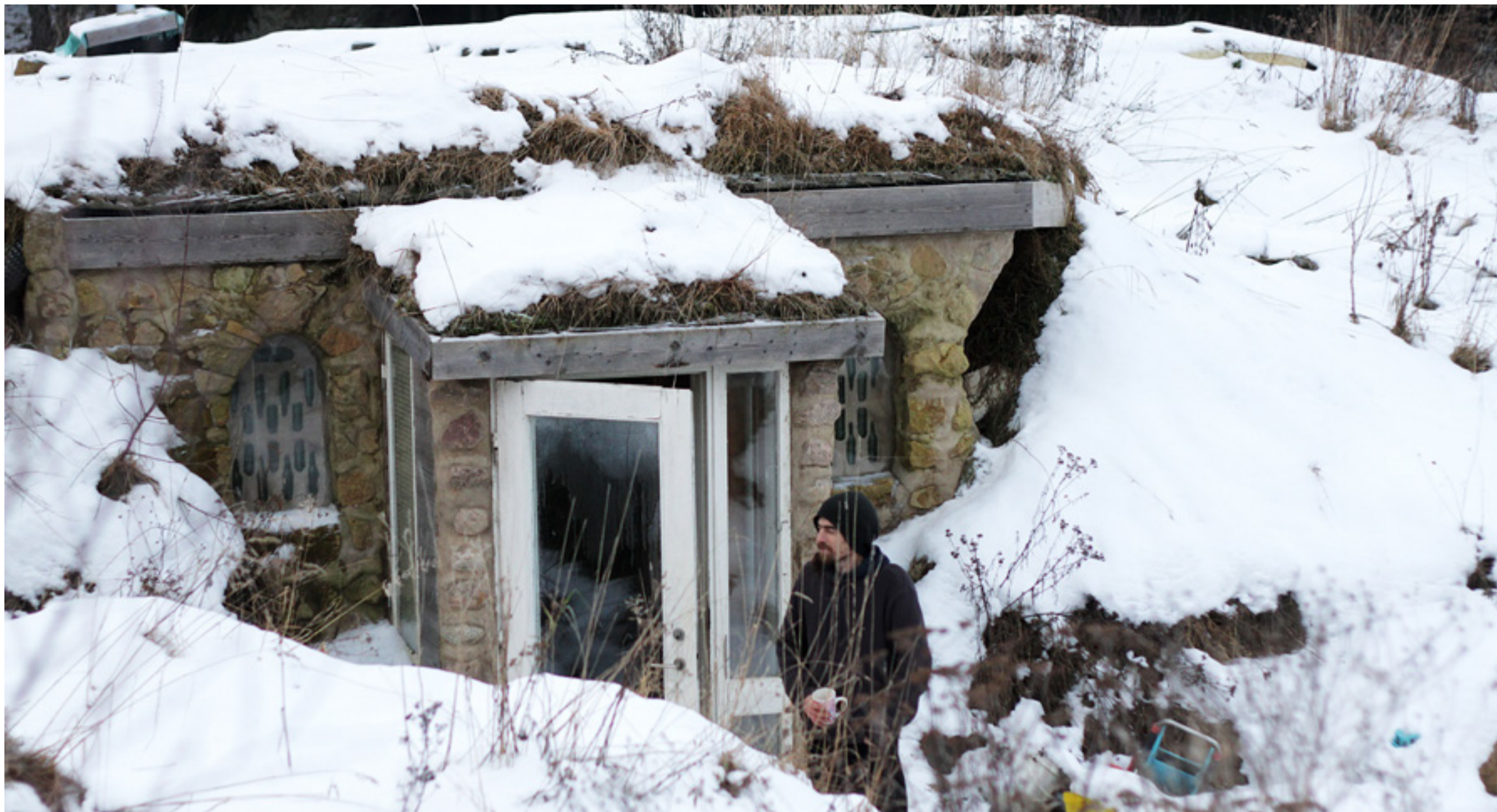
Kevin Schot och Sandra Brovall har byggt Sveriges första jordskepp – ett hus under jorden som nästan endast består av återvunnet material. Utifrån ser det ut som vilket jordkällare som helst, bara en vägg är täckt med fönster – de andra vetter in mot jorden.
