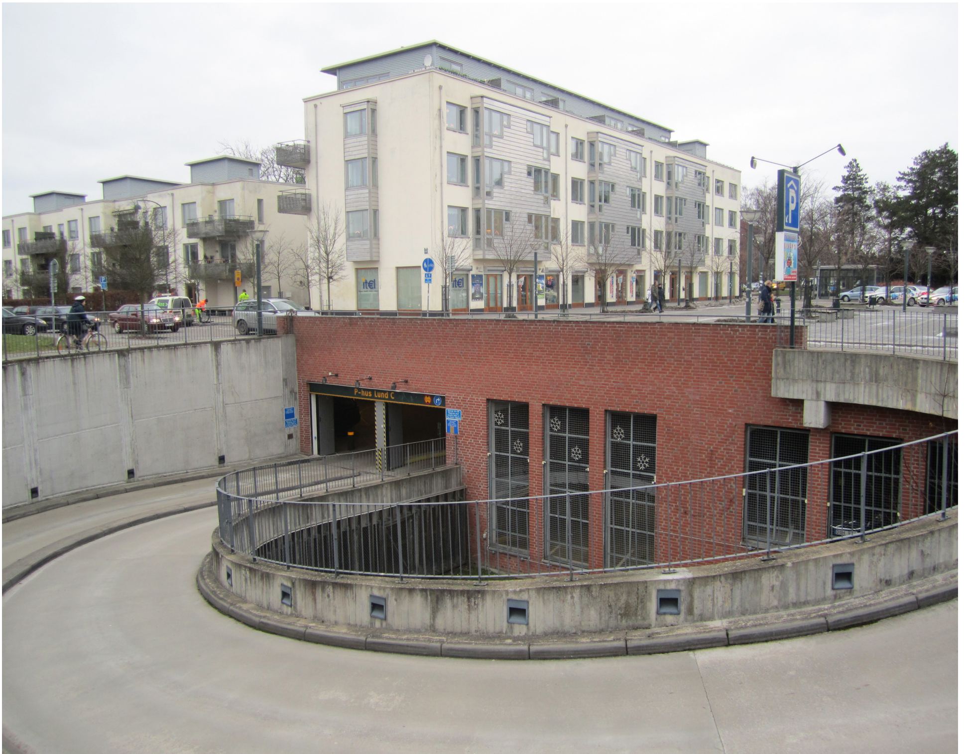
En väg ut från ett parkeringshus. Alla former är noga beräknade av svenska ingenjörer.
