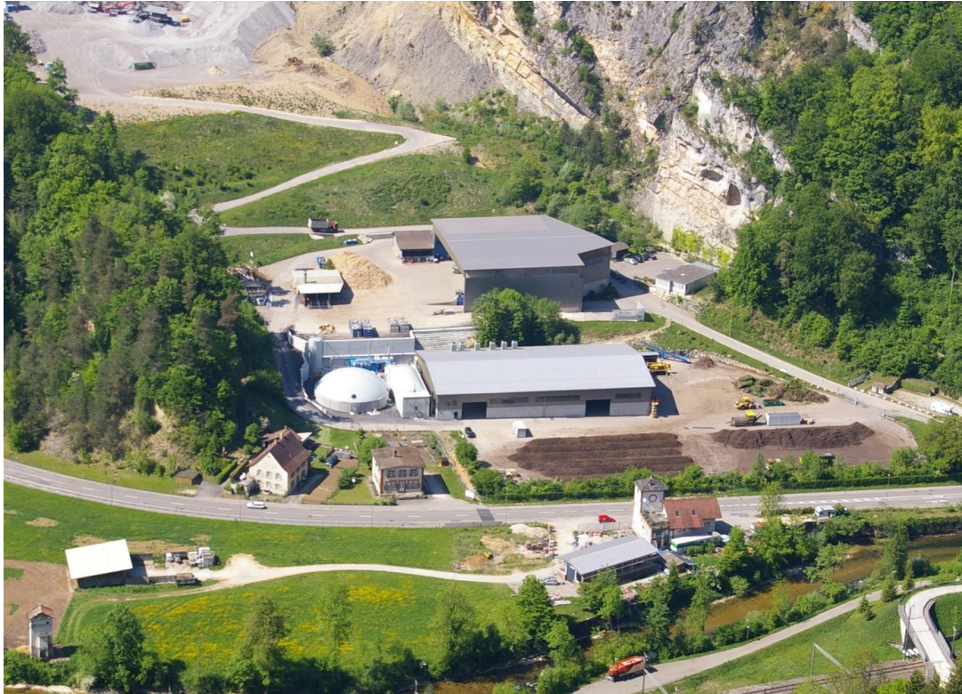
Figur 10 Biogasanläggningen i Liesberg har varit i drift sedan 2011. (Foto: EISENMANN).
