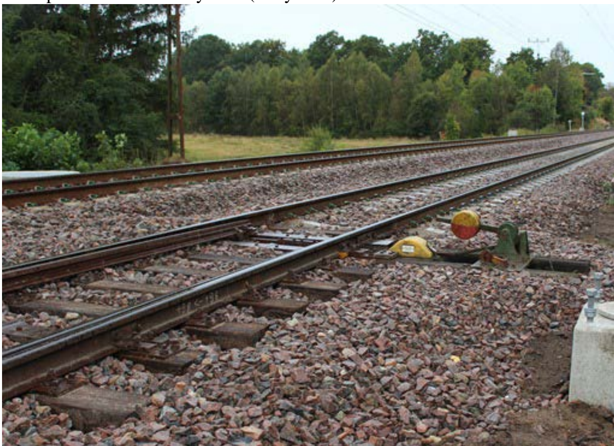
Figur 3 Klotomlagd växel med elektriskt växeltunglås i Västra Torup.
