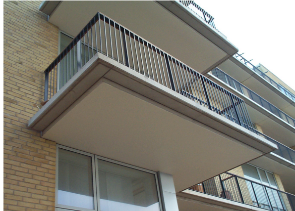
Figur 9 Denna bild är tagen på BO01 mässan i Malmö. Räckets infästningar är på ovansidan av plattan som är tunnare runt kanterna vilket ger ett lätt intryck samtidigt som man sparar på material och vikt. Foto: Dick Sjölund
