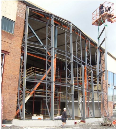
Figur 2.2: Montering av stomprofiler.
