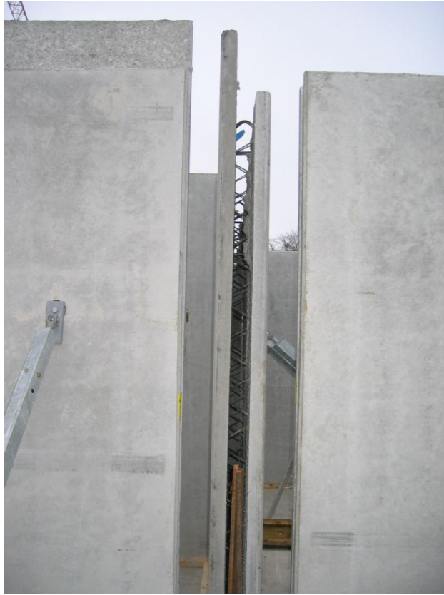
Figur 3.3 Skalvägg (Svensk betong, 2013).
