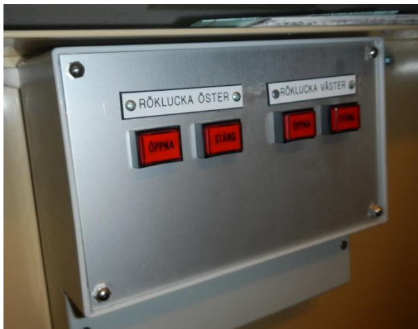
Figur 10. Visar de manuella knappar som används vid öppning av rökluckor i byggnaden.
