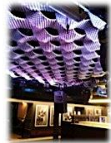
Figur 4.4. Taket i Galleriet med det ljudisolerande materialet.
