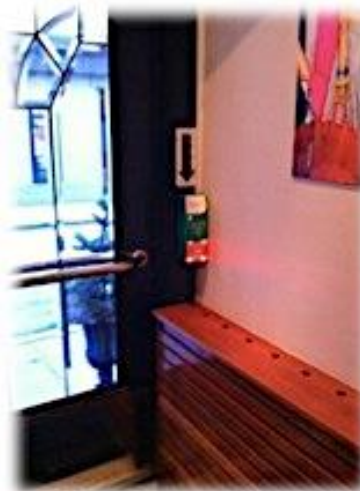
Figur 3.10. Bild på knappen för att låsa upp dörren vid utrymning. Dörrens handtag är placerad på öppningsknappens motsatta sida.
