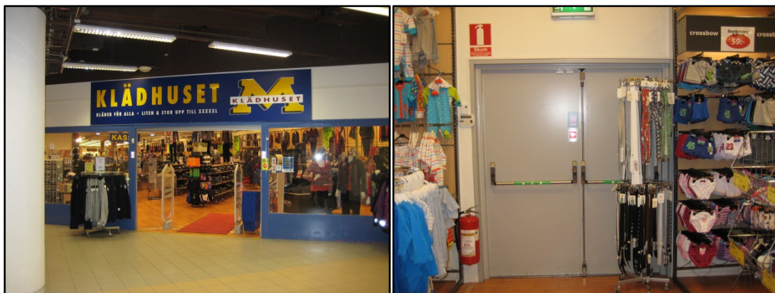
Figur 6.7. Klädhuset M inne på Sveaplan köpcentrum. Till höger en delvis blockerad utrymningsväg i Klädhuset.
