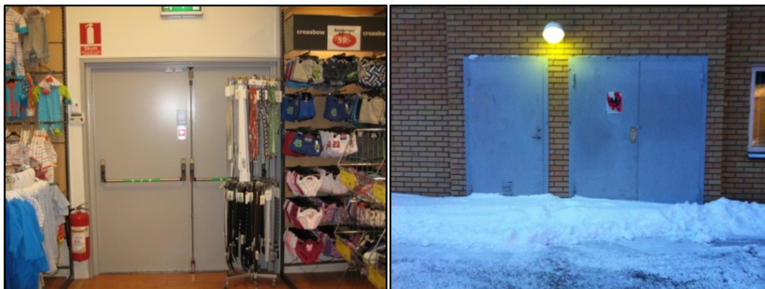
Figur 4.1. Vänstra bilden åskådliggör en delvis blockerad utrymningsdörr inne i Klädhuset M medan den högra bilden illustrerar en utrymningsdörr vilken är blockerad med snö.
