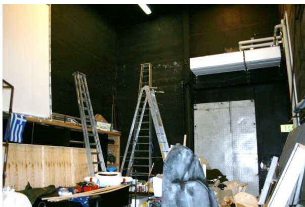
Figur 23: Blockerad utrymningsväg vid inlastningen till teaterscenen.
