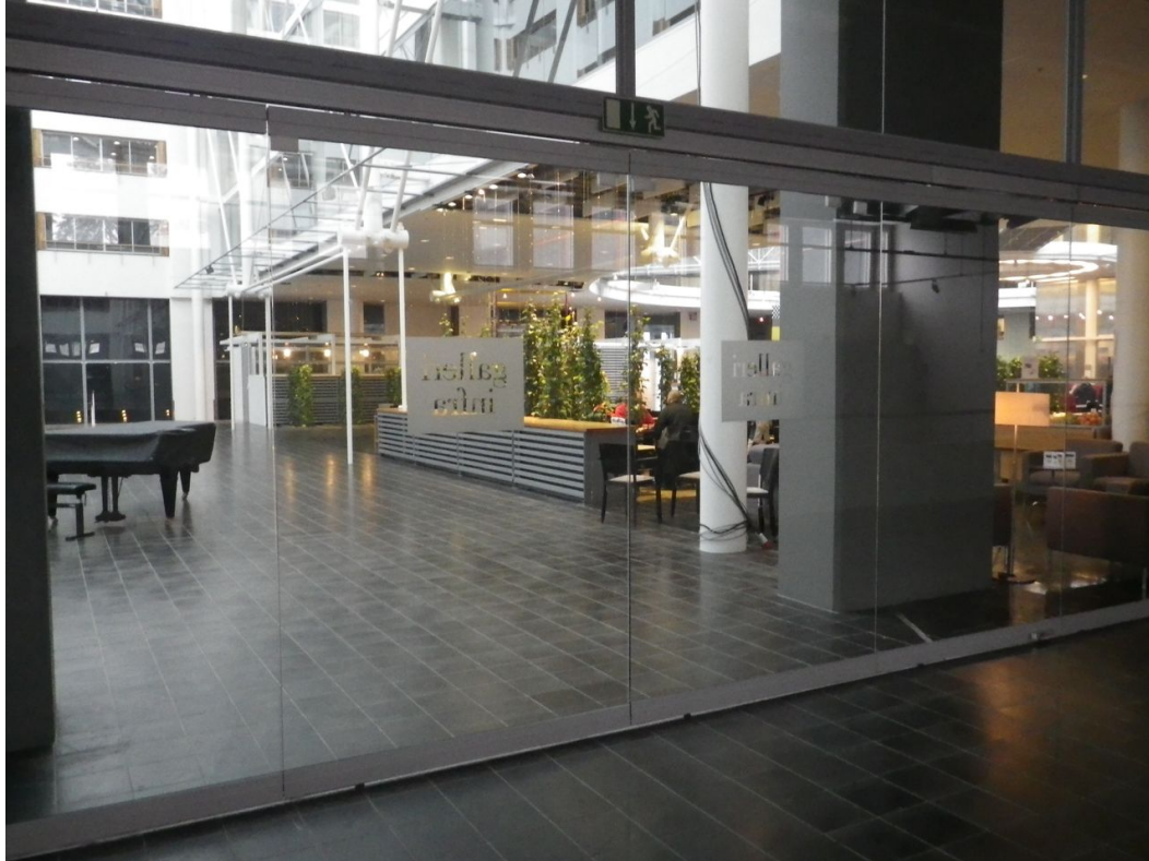
Figur 6.3. Utrymningsdörr i gallerian.
