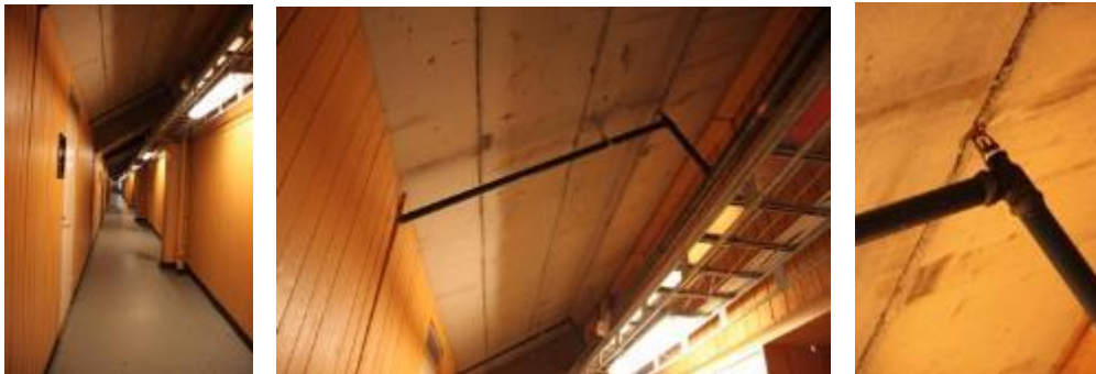
Figur 21. Sprinklat under sittläktaren i Lilla ishallen. (Foto: Malin Hanson, 2013).
