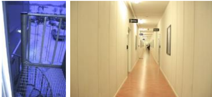
Figur 15. Föreningshallen, från vänster till höger: utrymningsvägen i slutet av korridoren i föreningshallen (höger i Figur 11), korridoren som leder till de olika föreningarna (Foto: Malin Hanson).
