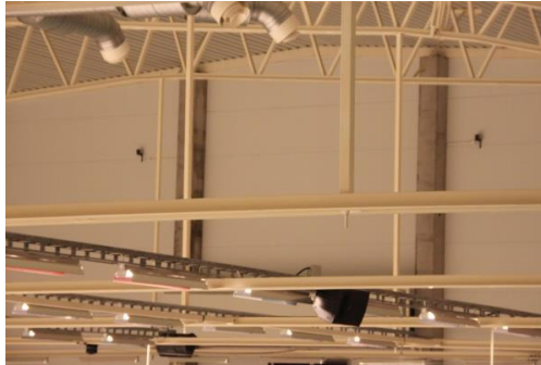
Figur 129. Stora ishallen (Foto: Malin Hanson, 2013). Linjerökdetektorernas placering på kortsidan.
