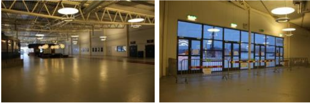
Figur 10. Den vänstra bilden visar bowlinghallens restaurangdel och i bakgrunden syns biljettluckan. I den högra bilden syns den blockerade utrymningsvägen. (Foto: Malin Hanson)
