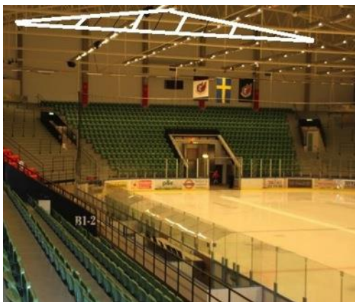
Figur 130. Stora ishallen (Foto: Malin Hanson, 2013). En grov uppskattning av hur volymen från tak till linjerökdetektorernas placering beräknats.
