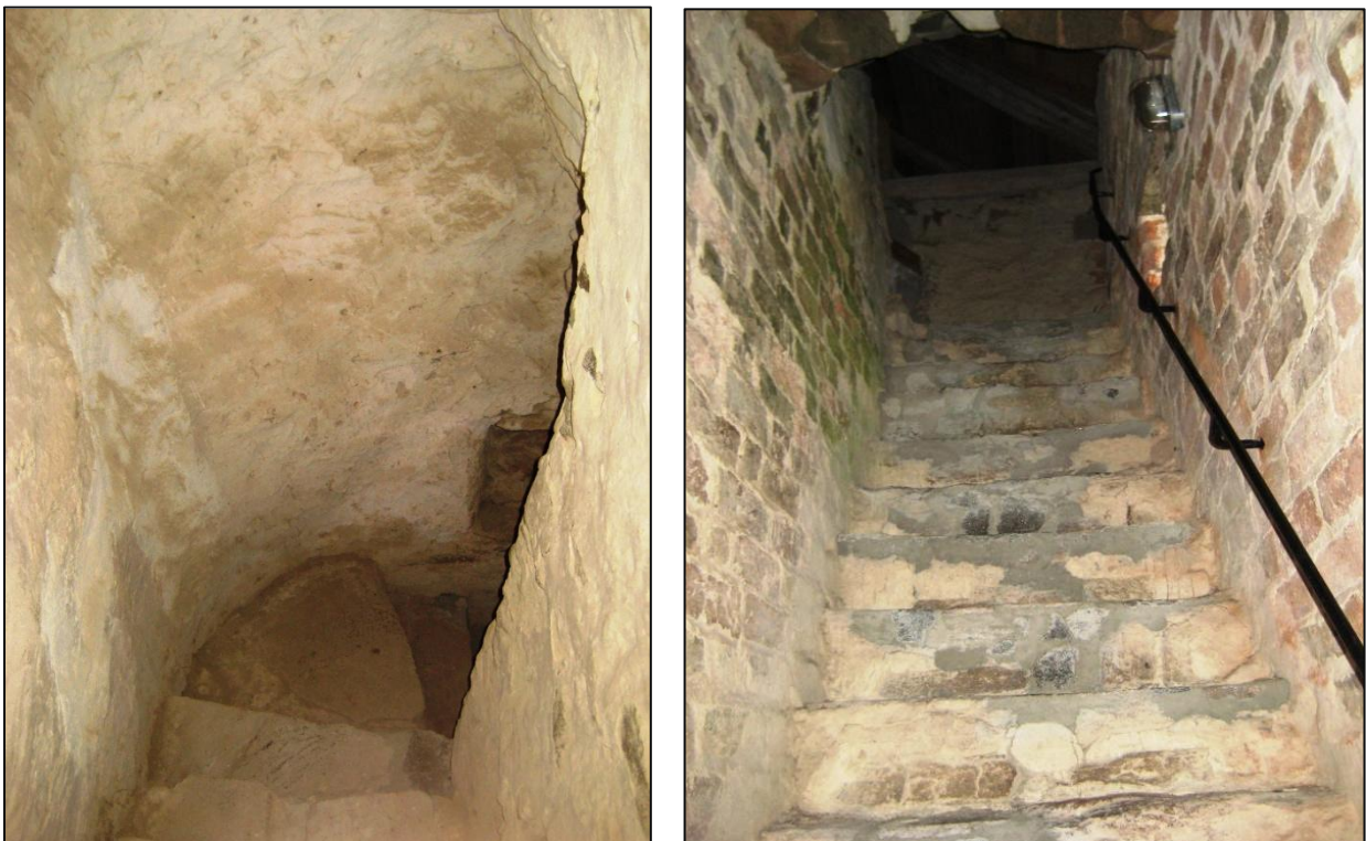
Figur 54 – T.v. trappan som murats igen i enda änden T.h. trappan som leder upp till vindsplanet från Gästrumsvåningen
