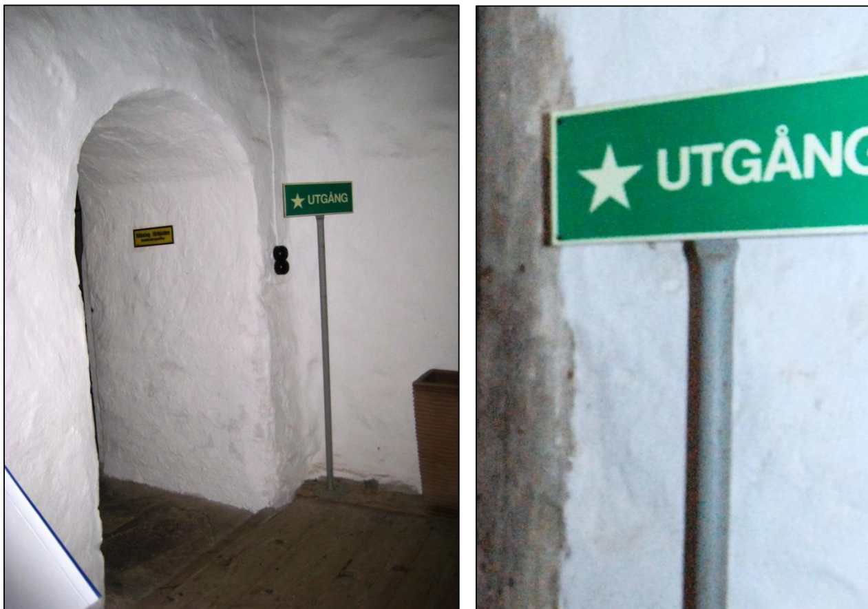
Figur 52 – Utrymningsskyltar som finns i Torpa Stenhus
