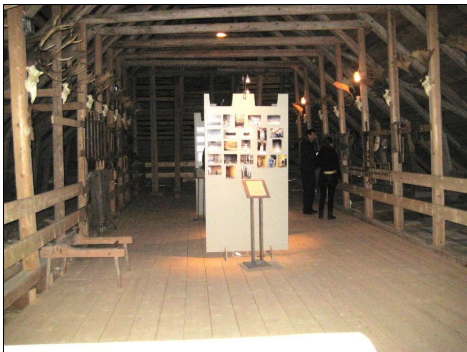
Figur 17 – Vindsplanet och byggnadens träramverk, i bilden syns också tavlor för utställning
