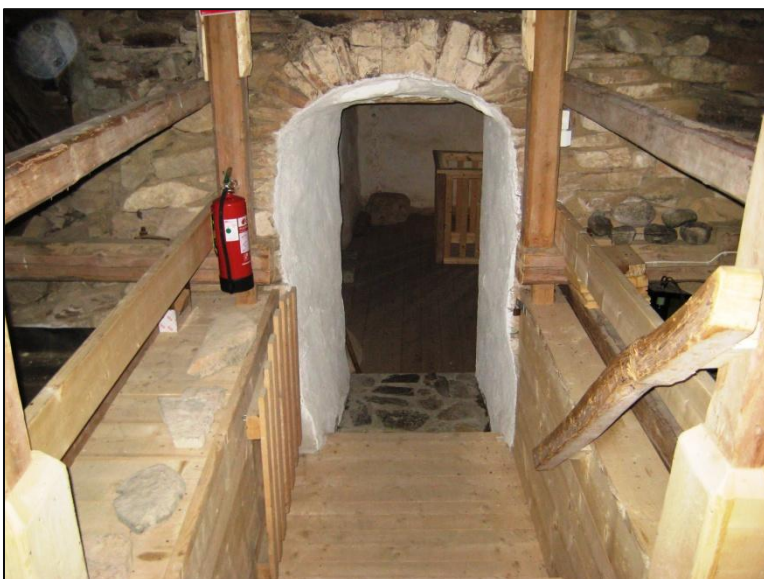
Figur 36 – Bild tagen från Vindsplanet ner i trapphuset, där trätrappan från våningsplan 3 inom trapphuset upp till Vindsplanet skymtar
