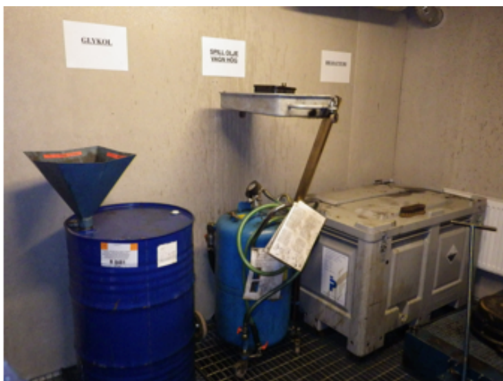
Figur 10. Insidan av förrådet där farligt avfall förvaras på Rönnebergsvägen 5. Platsbesök 2013-04-25.
