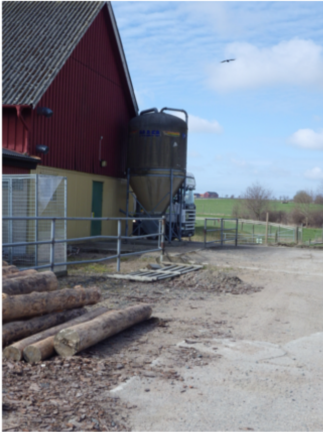
Figur 6. Silo för förvaring av pellets till pelletspanna. Platsbesök 2013-04-25.
