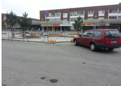
Bild 17 Bygandet av det nya Örtagårdstorget 90
