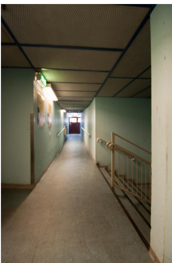
Figur 4.14 Korridor mot dörr ut till det fria
