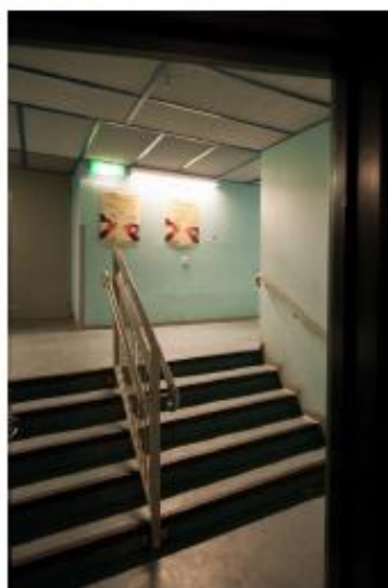
Figur 13 Den främre utrymningsvägen ut till korridoren
