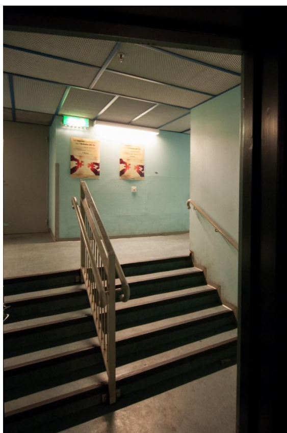
Figur 4.13 Främre utrymningsvägen ut till korridoren
