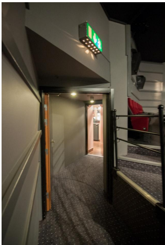
Figur 11 Den bakre utrymningsvägen ut till foajén
