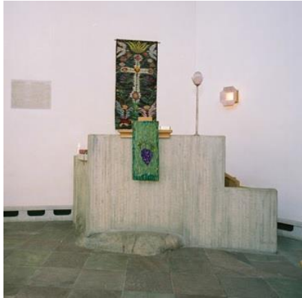
Bild2. Predikstolen i sin slutgiltiga utformning, helt gjuten i obehandlad betong. Platsen är relativt låg, men ändå tydligt markerad. Lägg märke till den granithäll på vilken predikstolen vilar.
