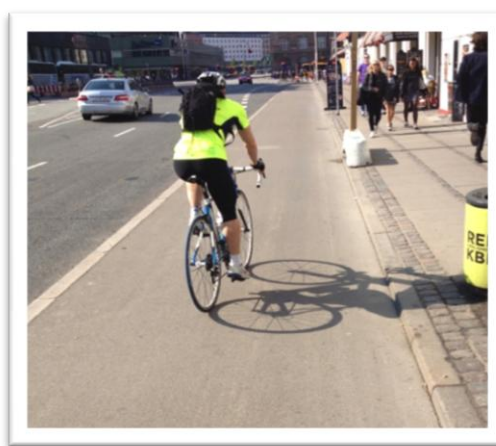
Figur 14: Till vänster visas hur Malmö separerat en dubbelriktad gång- och cykelbana med en skiljeremsa av kullersten. Till höger visas hur Köpenhamn använder en enkelriktad gang- och cykelsti, separerad med hjälp av nivåskillnad, (egna bilder).
