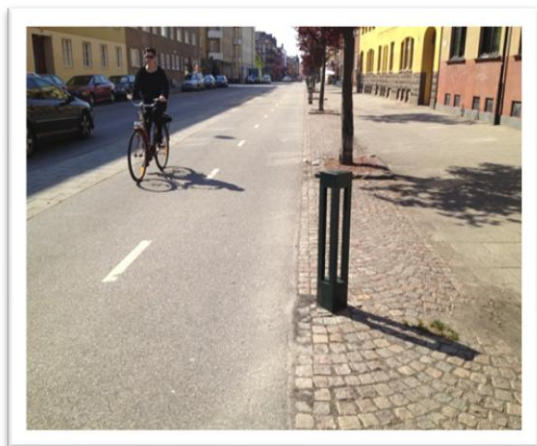
Figur 14: Till vänster visas hur Malmö separerat en dubbelriktad gång- och cykelbana med en skiljeremsa av kullersten. Till höger visas hur Köpenhamn använder en enkelriktad gang- och cykelsti, separerad med hjälp av nivåskillnad, (egna bilder).
