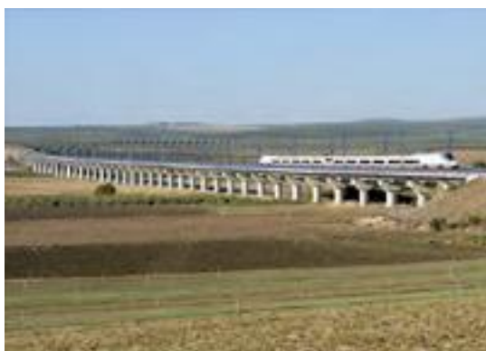
Figur 4: Viaducto Arroyo del Salado (Acciona, 2012).
