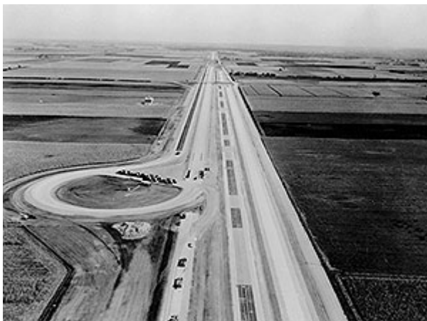
Figur 14 som visar byggandet av testslingorna (United States Department of Transportation, 2012).
