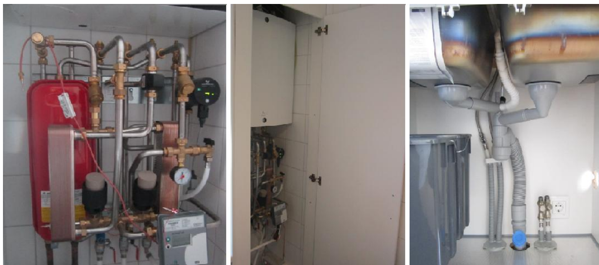
Figur 21 Bilder från en lägenhet på Diakonissan i Södra Råbylund. Till vänster: värmeväxlarenheten. I mitten: nederst värmeväxlarenheten och överst frånluftsaggregatet i ett skåp i badrummet. Till höger: Under diskbänken i köket syns diskmaskinens två extra rör längst till höger. [78]
