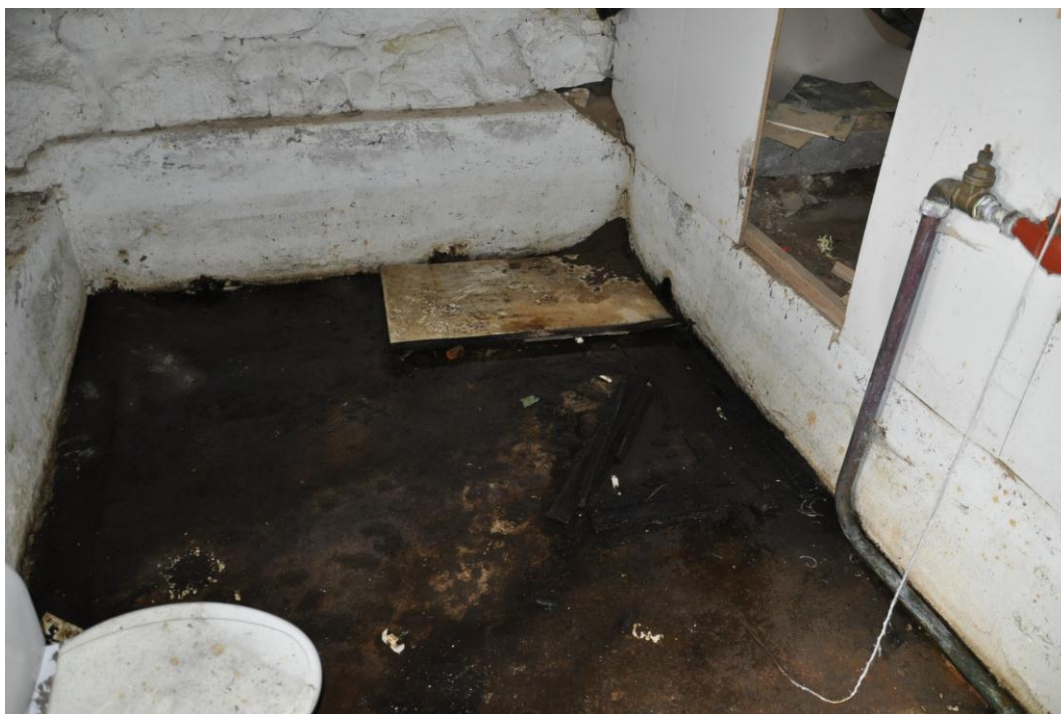
Figur 5: (C) Hanna Svensson Visar nedsänkningen av betong i hus 3. Resterande kryppgrund var i nivå med utrymmet till höger i bild.
