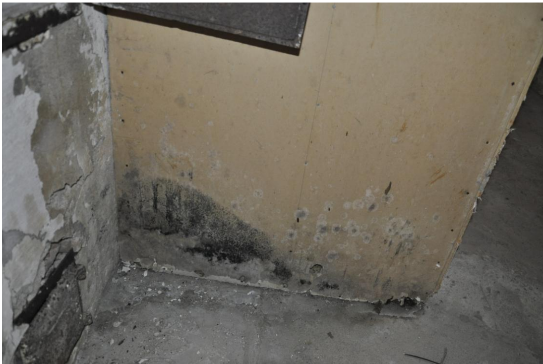
Figur 7: (C) Hanna Svensson Bild taget i hus 4 visar mögeltillväxt på gipsskiva.
