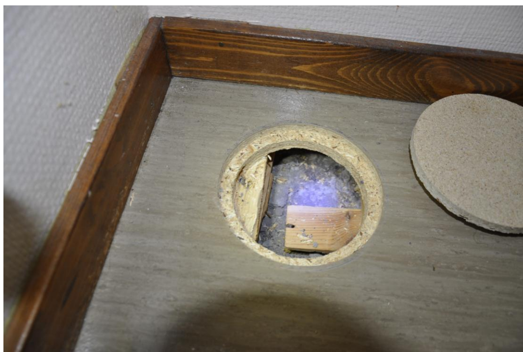
Figur 9: (C) Hanna Svensson Bild på mätpunkten Borrat hål (2) för hus 7.
