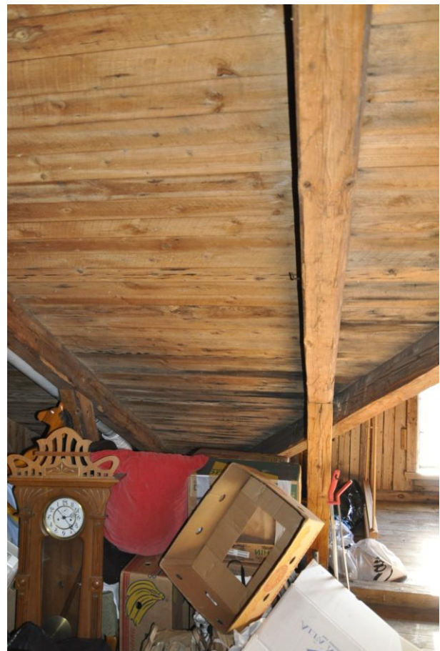
Figur 3: (C) Hanna Svensson Bild från vinden av missfärgning på råspont taget i hus 2.
