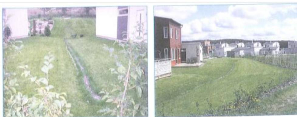
Figur 34. Vänster bild visar ett exempel på infiltrationsstråk mellan två fastigheter. Höger bild visar ett infiltrationsstråk i en gräsmatta. Det går även att se att byggnader lutar mot infiltrationsstråket (Svenskt Vatten, 2011).
