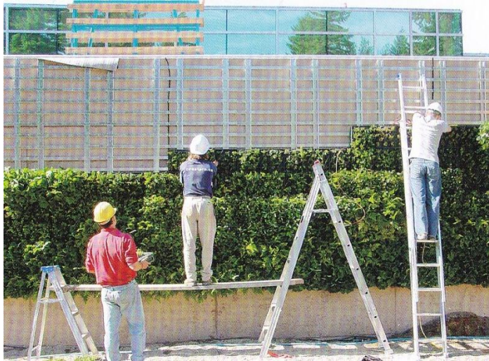
Figur 6: Montering av en modulär hydroponisk växtvägg i Vancouver, Canada. Källa: Dunnett & Kingsbury, 2008, s. 247.
