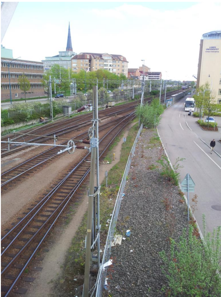
Bild 13. Järnvägsspåret som ska grävas ned i projektet Södertunneln.
