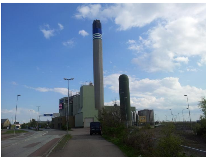
Bild 6. Öresundskraft AB:s fjärrvärmecentral.
