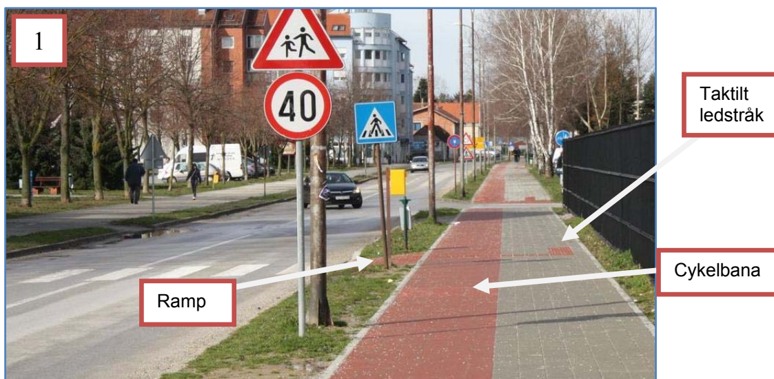
Figur 42: Bilden illustrerar kör-, gång- och cykelbana med ramp och taktila ledstråk.
