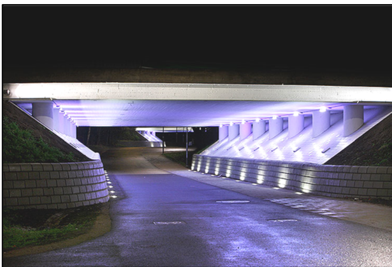
Figur 23: Upplyst och öppen gång- och cykeltunnel i Ryd, Linköping. (Tidran Design)
