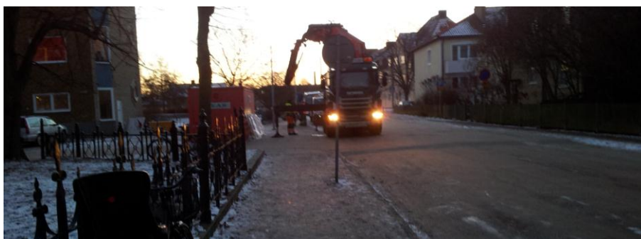
Figur 8-1 Ombyggnation vid S:t Olofsgatan och "vändzonen". (Egen).
