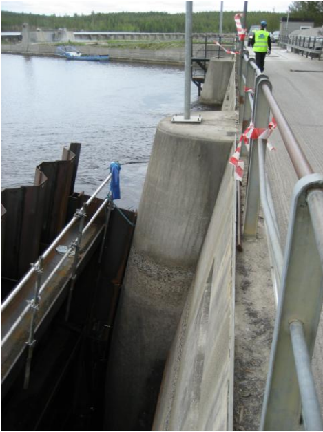
Figur 2.2 - Avskalning av täckskikt på uppströmssidan (Rosenqvist 2013).
