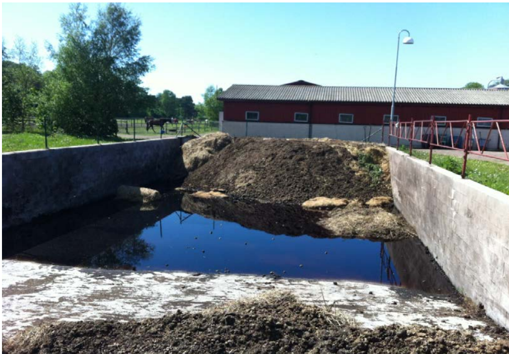
Figur7, Lomma ridklubbs gödselplatta. Gjutna platta med murade väggar sluttar i ena änden för att underlätta tömningen.
