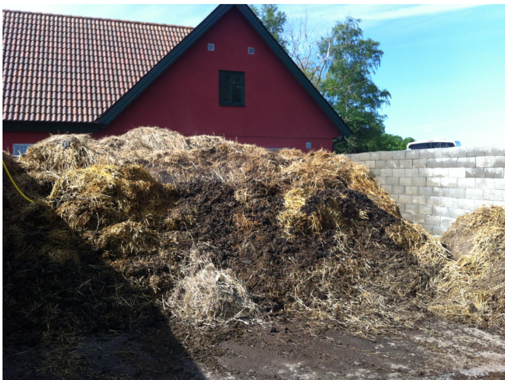
Figur 9, gödsellagring Champagnegården, helgjuten platta med 2 meter höga murade väggar.
