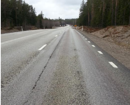
Bild 9. Längsgående spricka
