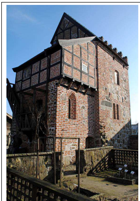
Fig 13: Dekanhuset (Vilhelm Dresselbergs residens). Kvarstående delar av ursprungshuset till vänster, tillbyggt tornhus till höger. (Foto Irene Hansen 2014)
