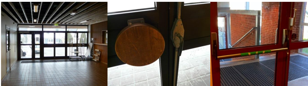
Bild 11 – På bilden till vänster ses entrén i foajén, på bilden i mitten ses det nuvarande beslaget och på bilden till höger ses ett modernt beslag.
