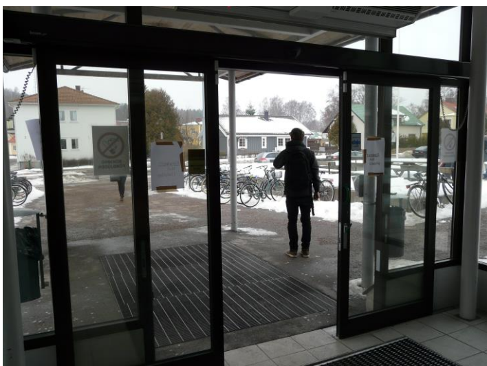
Bild 12 – Skjutdörrar som inte öppnar helt och därmed riskerar att försvåra utrymning.
