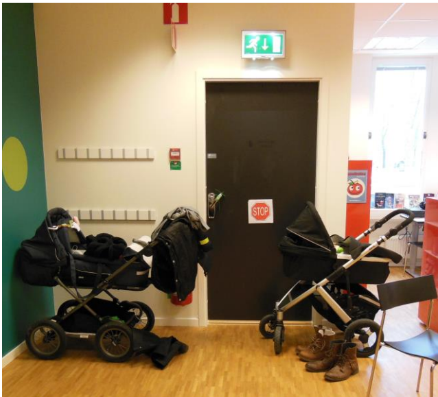
Figur 30. Bild från platsbesök över blockerad utrymningsväg i biblioteket
