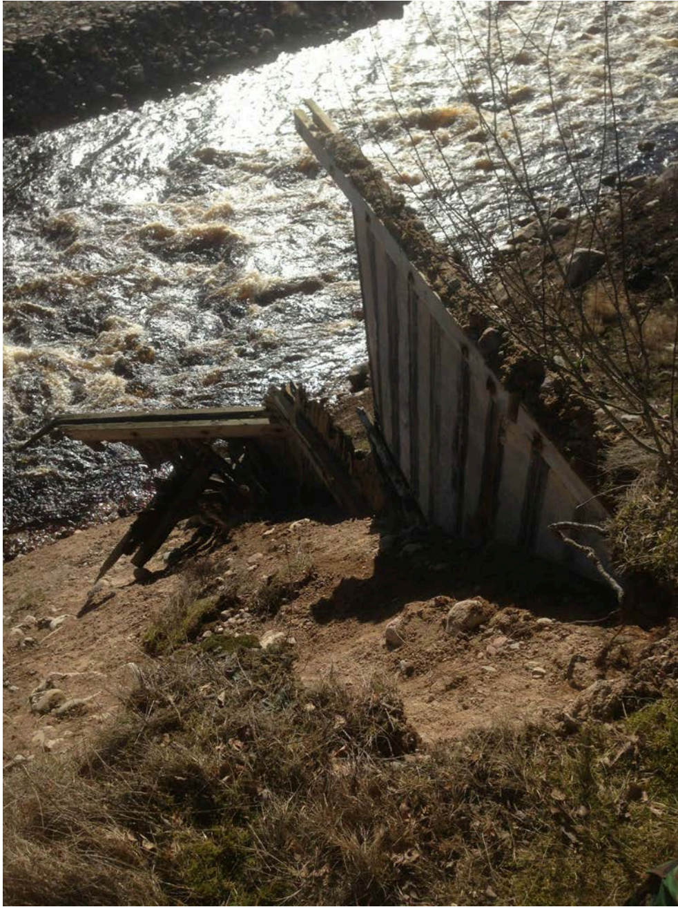
En närbild på spanten i vänster dammvall och det strömmande vattnet i åfåran.
