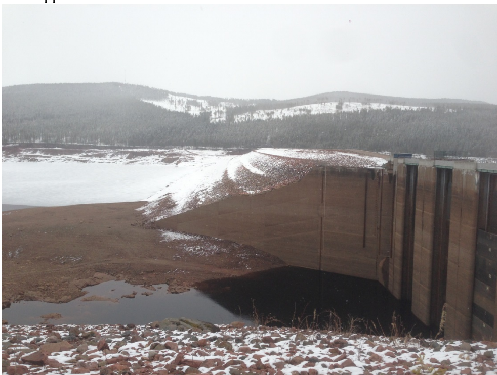
Det ena utskovet med intag, samt uppströmssidan.
