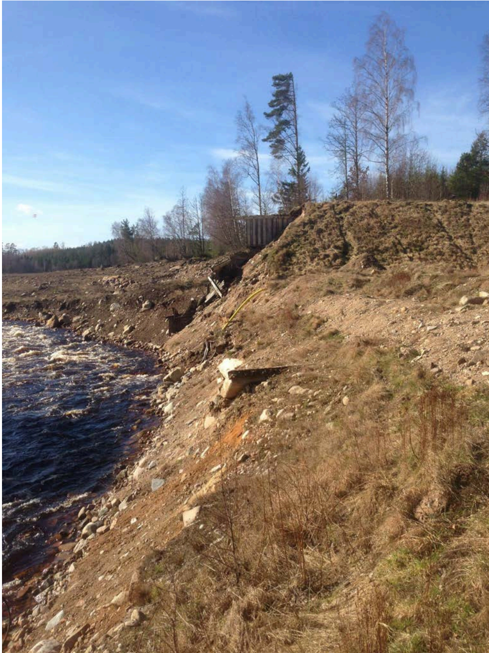
Resterna av vänster dammvall med delar av sponten som sticker ut ur vallen.
