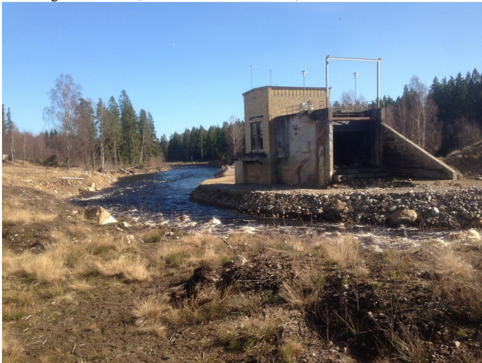
Kraftverksbyggnaden och intaget från uppströmssidan.
